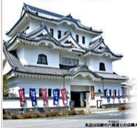
本店は伝統の八幡造りの店舗です
